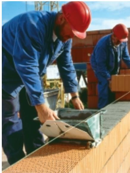
Bild 8 Vollflächiger Mörtelauftrag
