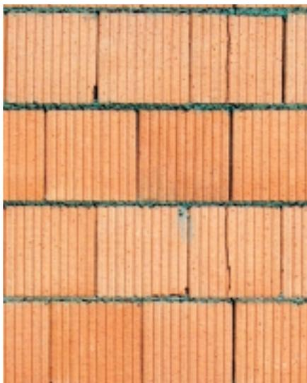
Bild 12 Über mehrere Steinlagen hinweggehender Riss z. B. aus Bauwerkssetzungen
