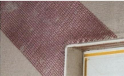
Bild 4 Beispiel einer Diagonalbewehrung
