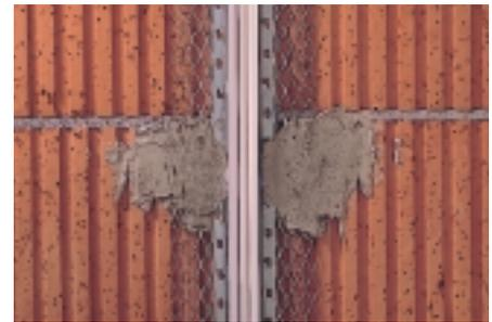
Bild 13 Dehnfugenprofil
